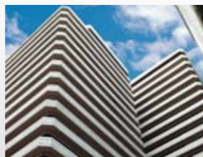
NIX (THAILAND) LTD.
